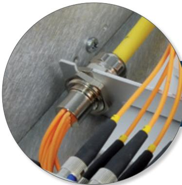
Spezialbefestigung für die ordentliche und saubere Ablage von zwei „ICoNet24- Kabelaufteilern“.
